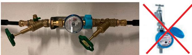
Es ist ein Wasserzählerbügel einzubauen, sowie vor dem Zähler ein Absperrventil und hinter dem Zähler ein KFR-Ventil zu setzen. Eine Verplombung findet in Fließrichtung an der Verschraubung des Zwischenzählers statt. Die offizielle Plombe der Stadtwerke Porta Westfalica GmbH erhalten Sie entweder von Ihrem Installateur oder von uns kostenfrei.
